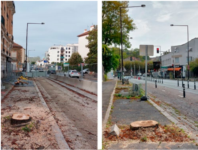
Au lendemain de l'abattage des arbres sur la départementale D37, à Montreuil
